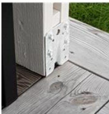
Figur 4: Förlängning av altanräcke samt infästning mot trallgolv och befintlig skiljevägg.
