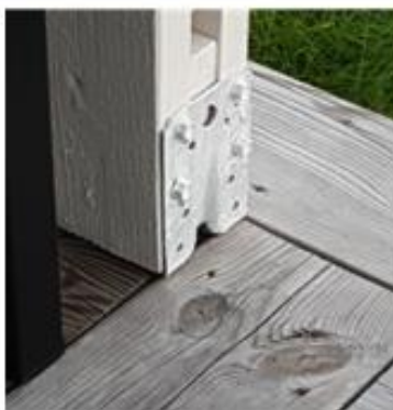
Figur 3: Förlängning av altanräcke samt infästning mot trallgolv och befintlig skiljevägg.
